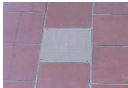
Per la loro estetica e funzionalità le griglie e i coperchi in PVC trovano un'ideale applicazione su tutte le pavimentazioni in genere. I telai, griglie e coperchi per le loro caratteristiche dielettriche e autoestinguenti sono indicati per impianti elettrici. I prodotti della **serie 2000** e **Supergriglia**® sono idonei nelle applicazioni dove si richiede un'elevata resistenza ai carichi. La griglia e il coperchio leggeri sono idonei nelle aree di passaggio pedonale.
