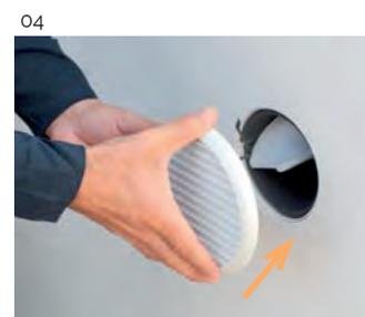
04 Installare la griglia di ventilazione
