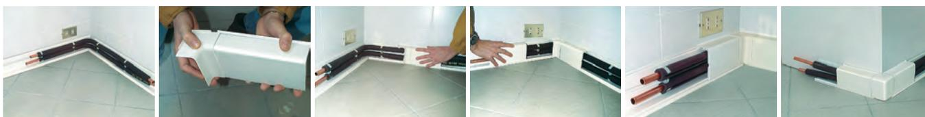
Posizionamento delle tubazioni ed assemblaggio del raccordo angolare con il profilo.
