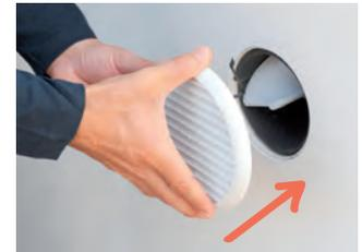
Installare la griglia di ventilazione
