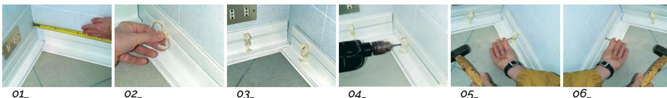
01\_ Posizionare i profili PTL2000 in appoggio alle pareti (01) e misurare la distanza di 150 mm circa dall'angolo parete per l'inserimento delle staffe portatubi (utilizzare tubi dal Ø22 al Ø28 mm.). Inserendo la staffa (ST28) nell'apposita guida del profilo ogni 500 mm e svolgendo una semplice rotazione in senso orario (02) avviene il bloccaggio consentendo il corretto posizionamento delle tubazioni (03)
